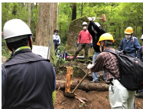
丸太階段を止める支柱を打ち込む参加者
